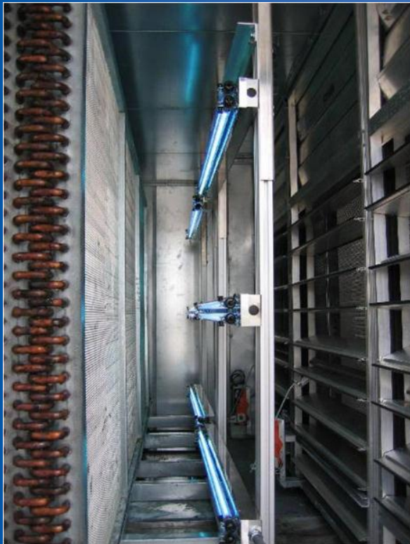
Tratamiento de Serpentín
